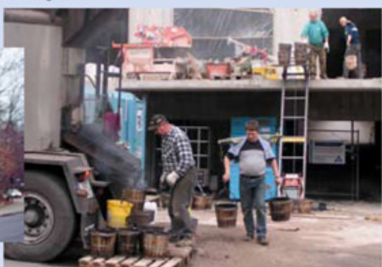
Im Frühjahr 2008 war die „heiße Phase“ des Baugeschehens. Bis zu 40 Männer arbeiteten gleichzeitig auf der Baustelle, um den Eröffnungstermin im April 2008 zu halten.
